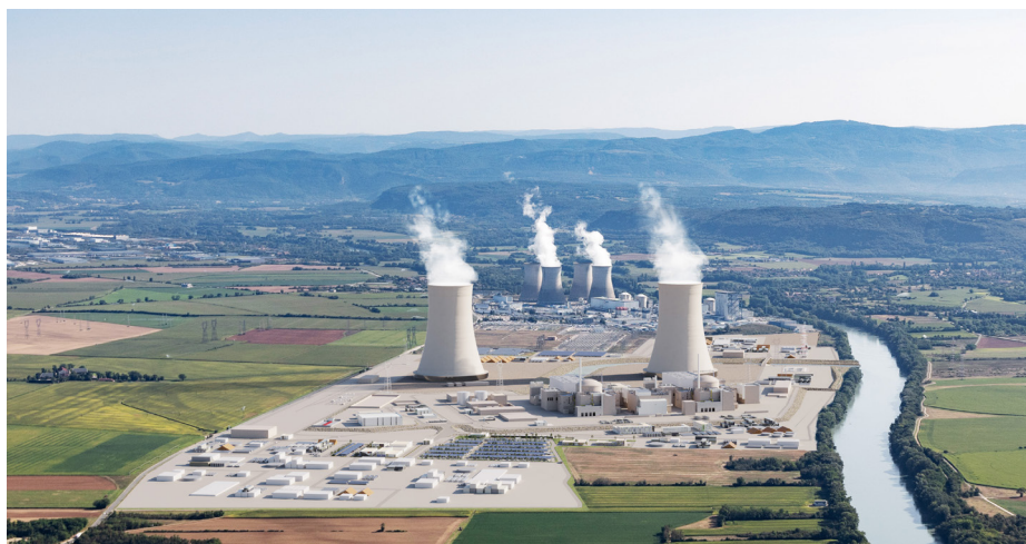
Simulation du projet EPR2 avec, en arrière-plan, le site actuel. Les réacteurs EPR2 utilisent la même technologie que les réacteurs du CNPE avec des dispositifs supplémentaires de sûreté et une puissance supérieure (1760 MWe au lieu de 910 MWe).
