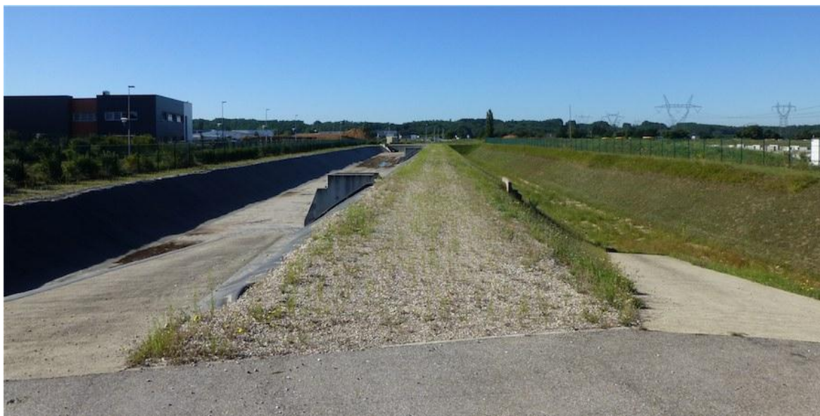
Bassin de rétention-infiltration de la zone d'activité du Chanay.
