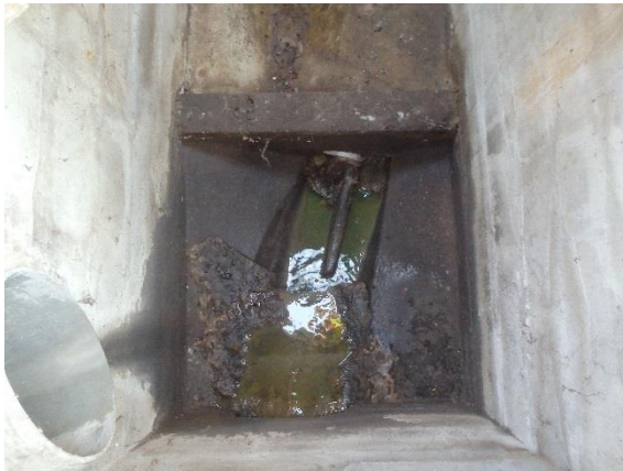
DO 5 (Rue du Plâtre)
