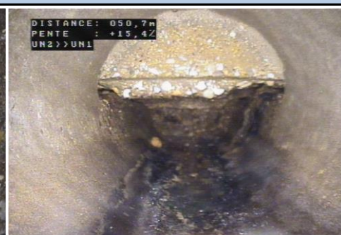
Elément de maçonnerie descendant
