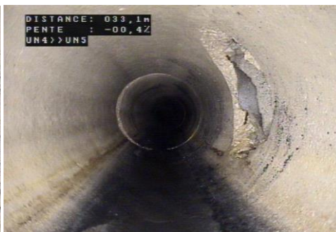
Raccordement défectueux
