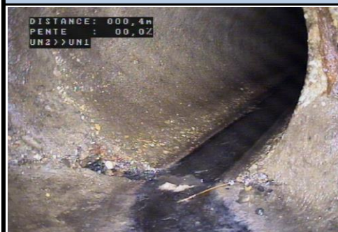
Mortier manquant
