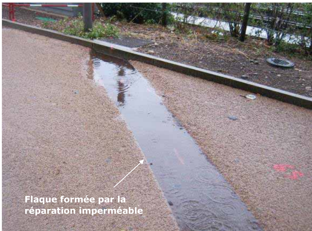
Enrobé poreux sur la piste cyclable du tram T3, Vaulx-en-Velin
