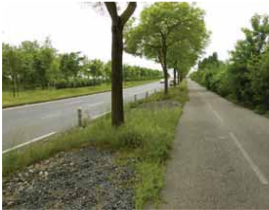
Tranchée drainante, boulevard des Droits de l'Homme, Bron
