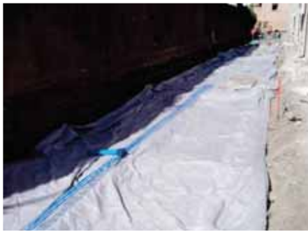
Création d'une structure réservoir, rue François Jacob, Lyon
