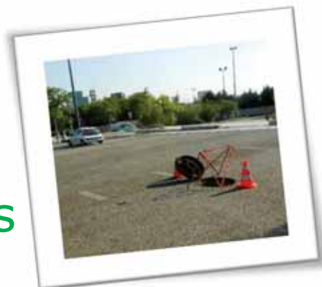
Au-dessus d'une structure réservoir enterrée
