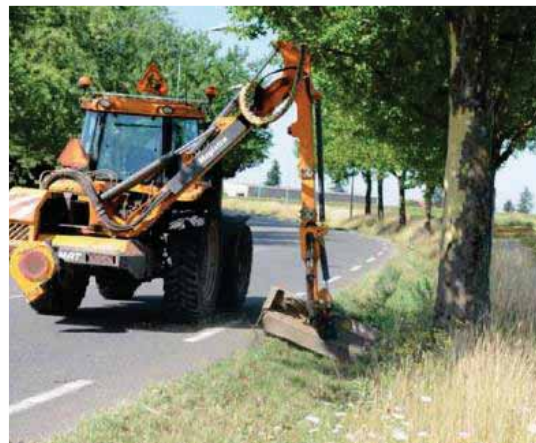
Fauchage mécanisé d'une noue
