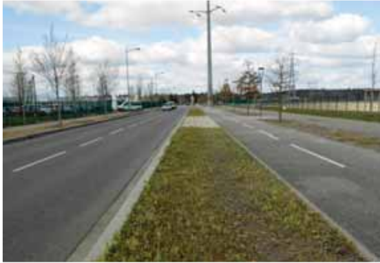
Tranchée drainante le long d'une voirie, Lyon
