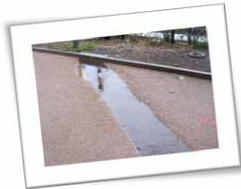
Revêtement poreux, Vaulx-en-Velin
