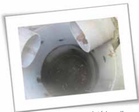
Intérieur d'un puits d'infiltration
