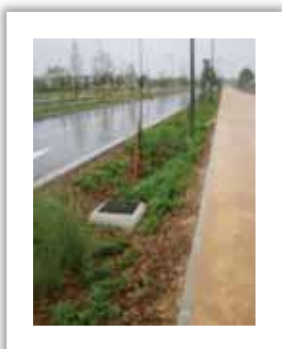
Séparation par des noues des voies voitures/bus/cyclables : Boulevard Urbain Est, Lyon
