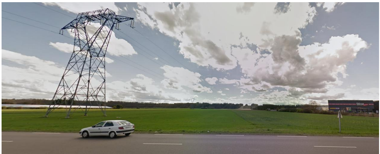
Corridor vue depuis la RD306 en direction du Sud (vers le coteau Nord de Saint-Bonnet)
