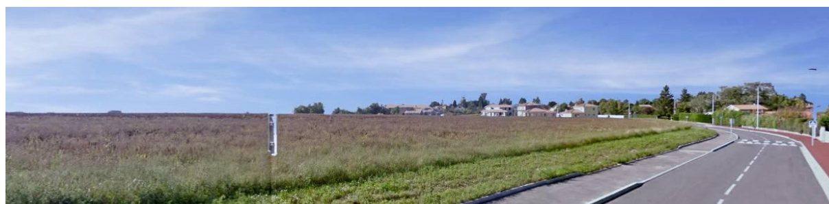
Vue depuis l'avenue du Gay vers le Sud-Ouest
