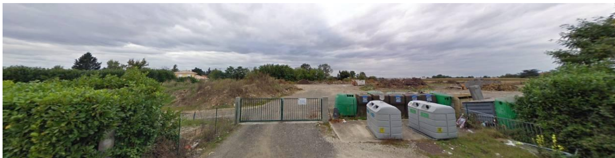
Vue depuis la route de Dormon en face de l'accès actuel
